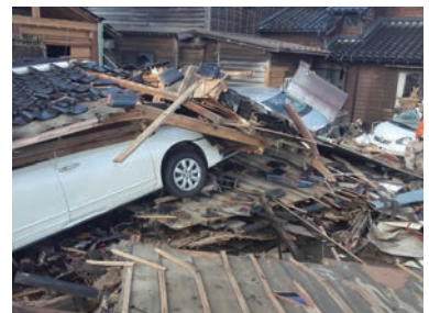
▲ 能登半島地震・珠洲市にて被害調査を行う
