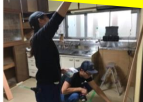
空き家の改修
